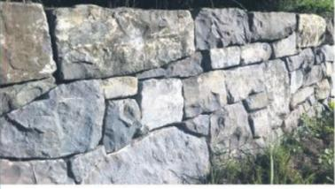
Der Bau von Trockensteinmauern ist eine jahrhundertalte traditionsreiche Bautechnik, bei welcher die bearbeiteten Steine ohne Beton oder sonstige Bindemittel Schicht für Schicht zu einer selbsttragenden Mauer aufgebaut werden.
